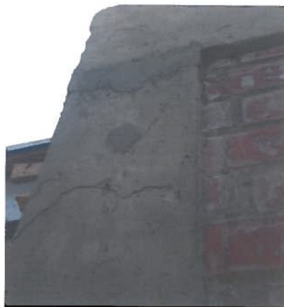
Foto N° 3 – Pilar de muro medianero.
